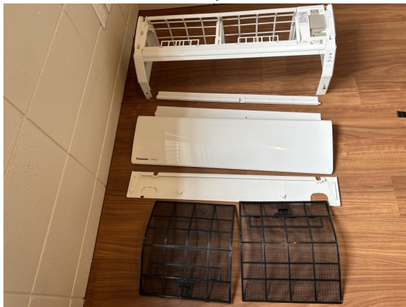
19.エアコンクリーニング
