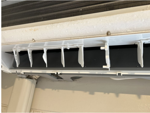
19.エアコンクリーニング
