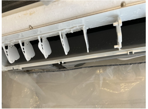
19.エアコンクリーニング
