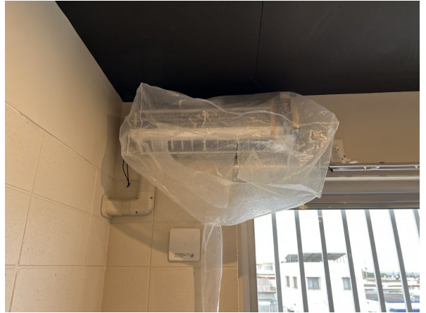
19.エアコンクリーニング
